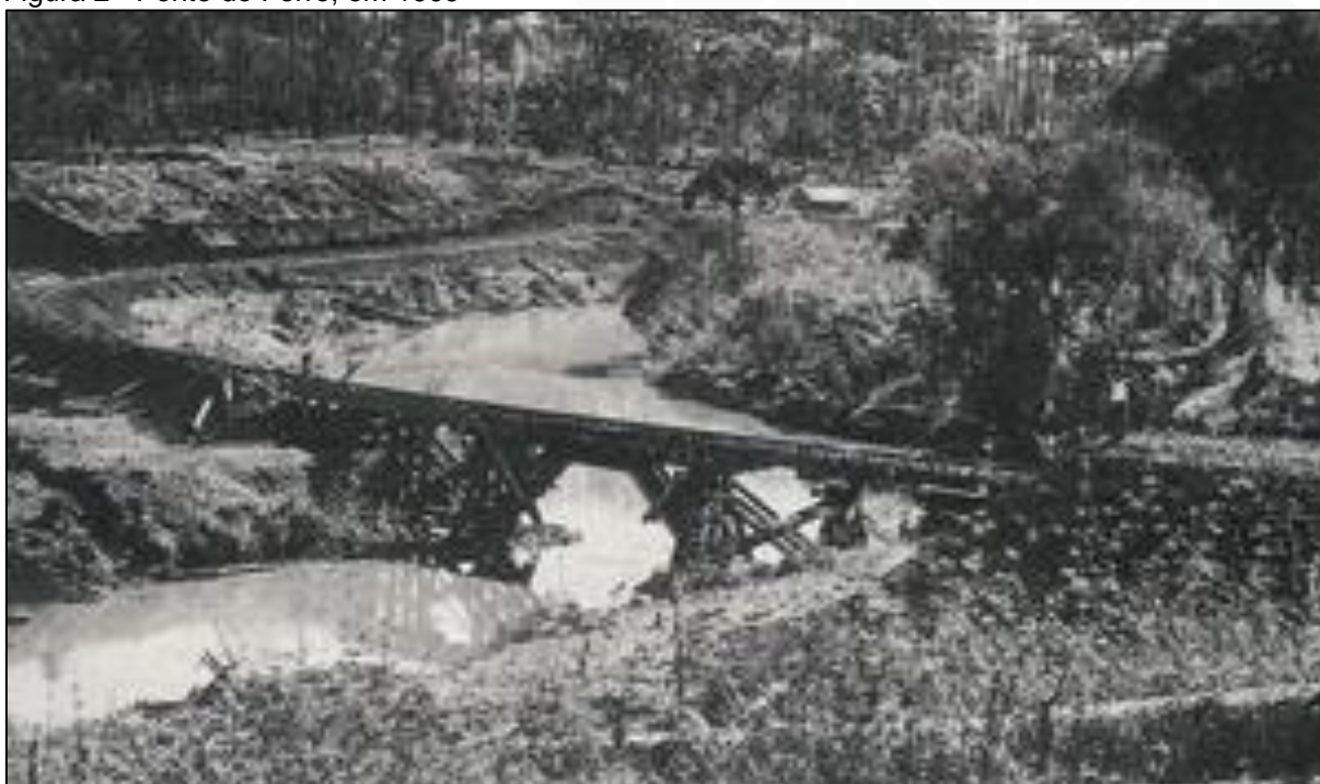
Figura 2 - Ponte de Ferro, em 1909
