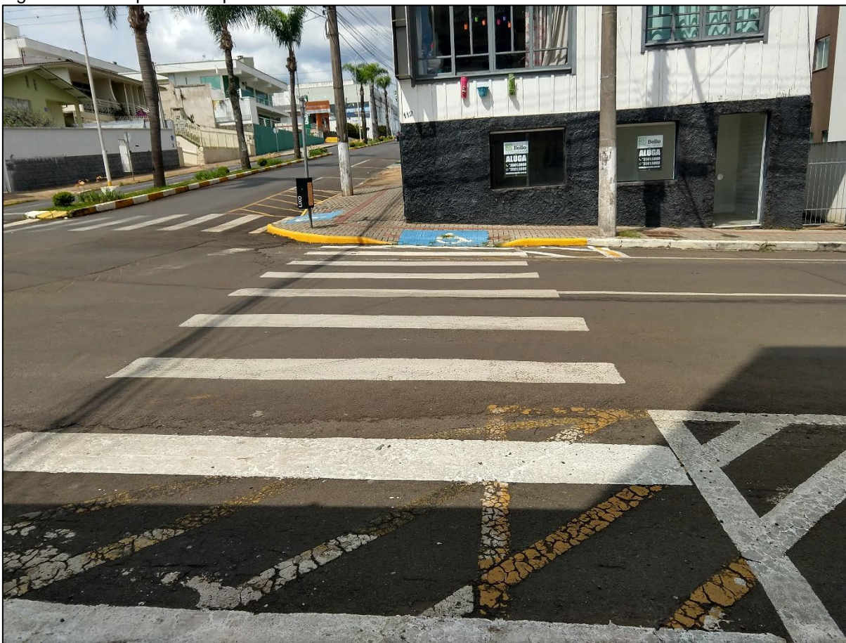
Figura 67 - Rampa e faixa para travessia na Rua Conselheiro Mafra
