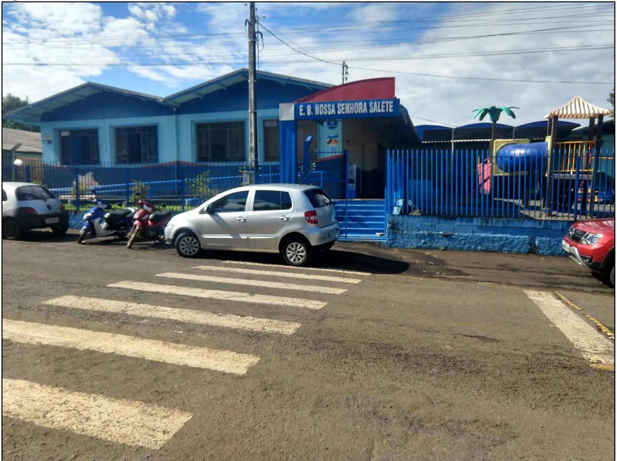
Figura 71 – Rua Santa Bárbara
