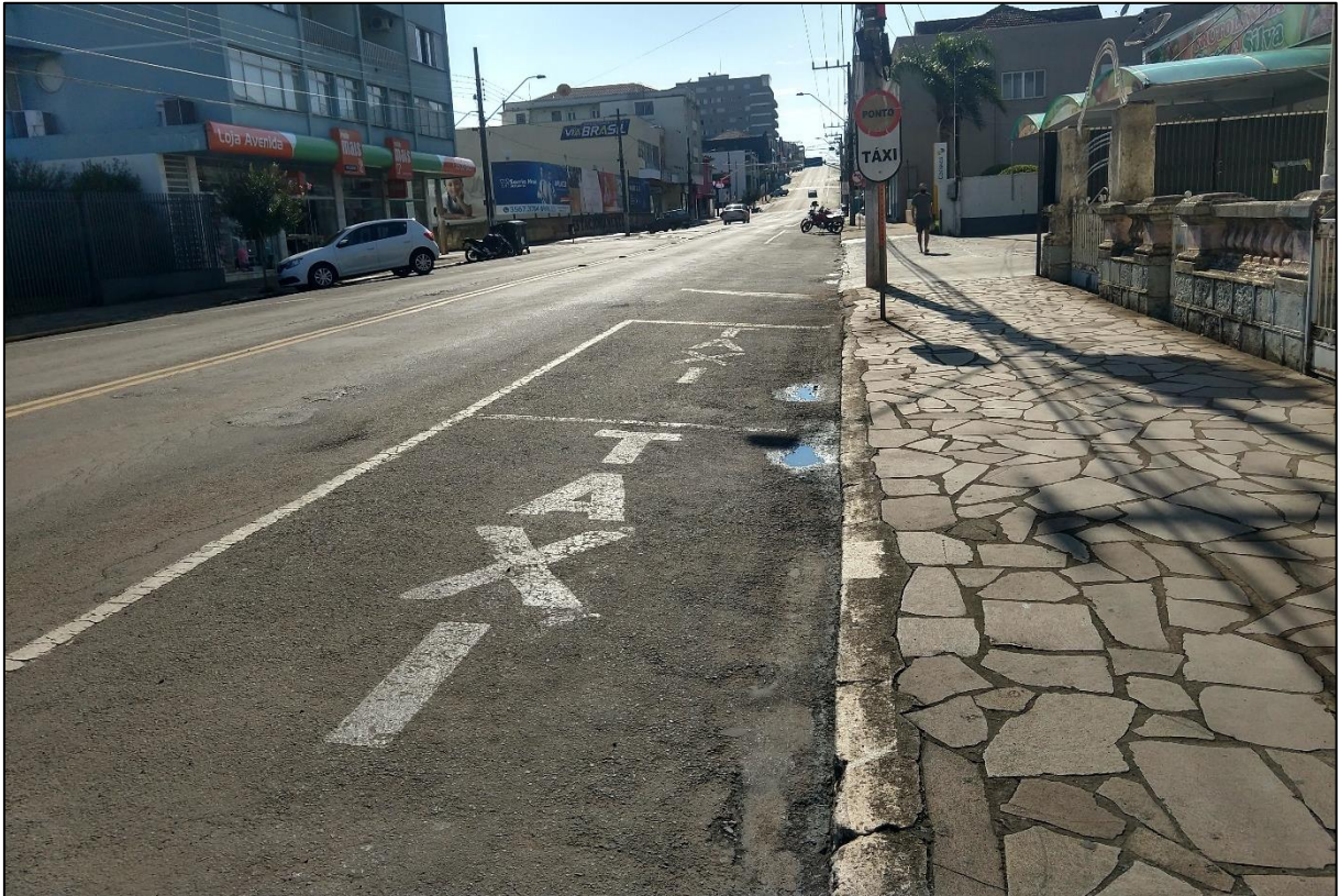
Figura 126 – Ponto nº 11 – Avenida Barão do Rio Branco
