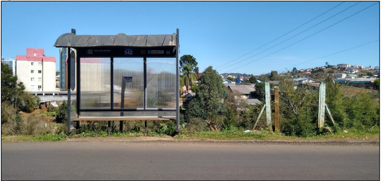
Figura 120 – Ponto de ônibus implantado diretamente no acostamento da via
