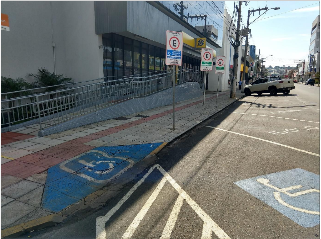
Figura 135 - Vagas para pessoa com deficiência e idosos na avenida Barão do Rio Branco
