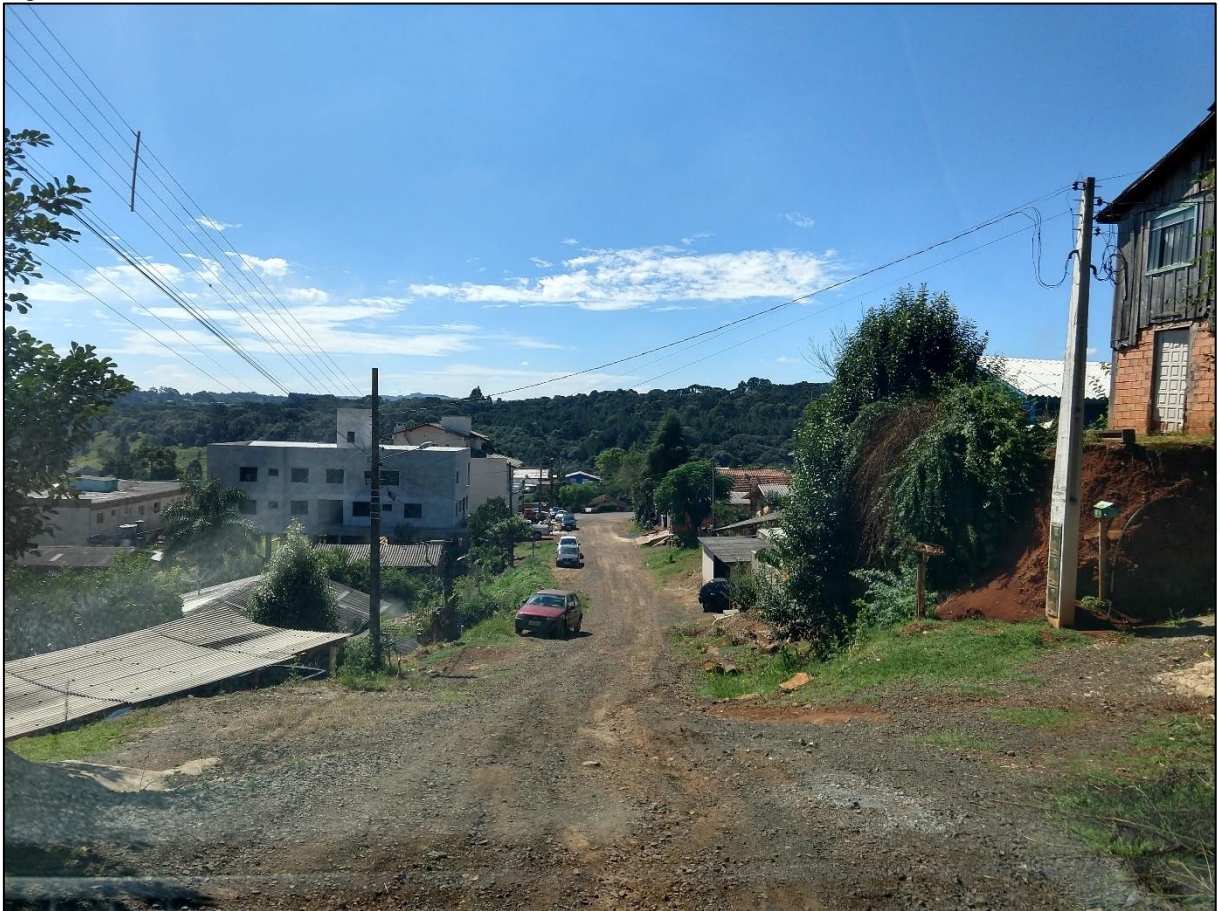
Figura 61 - Rua Antônio Rotta
