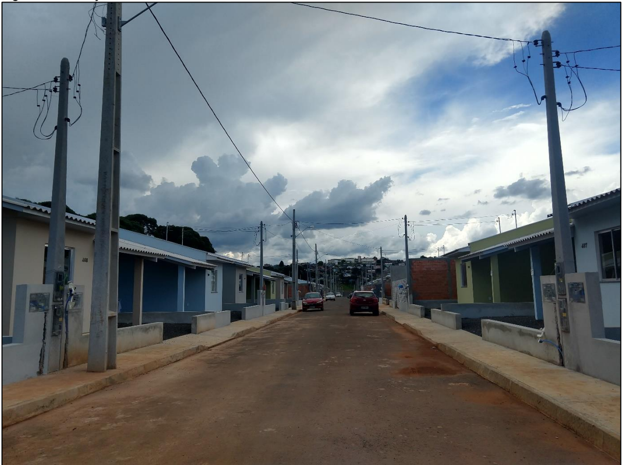
Figura 64 – Calçada na rua C Loteamento Cidade Nova
