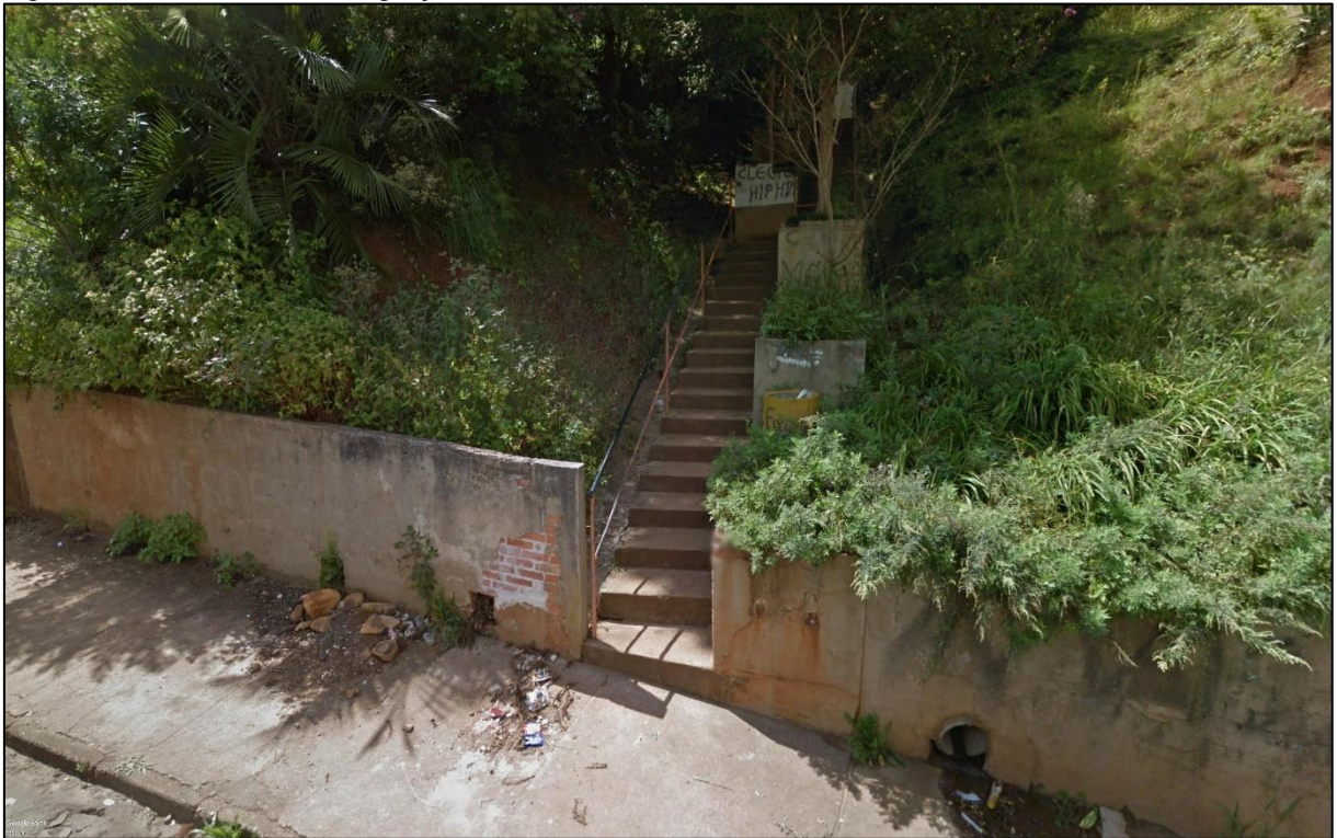
Figura 77 - Escadaria de integração entre a rua Luiz Tortatto e a rua João Benetti Sobrinho
