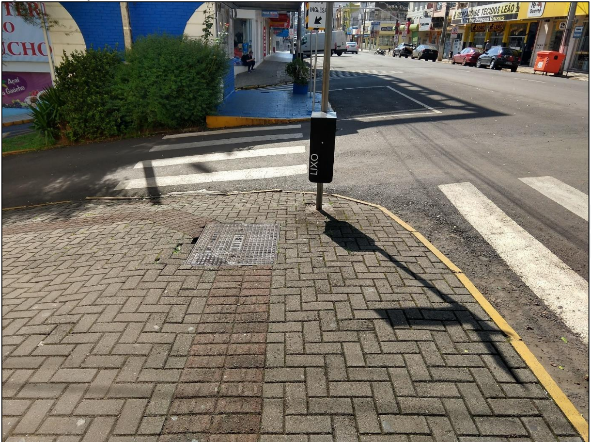
Figura 51 - Calçada na avenida Barão do Rio Branco
