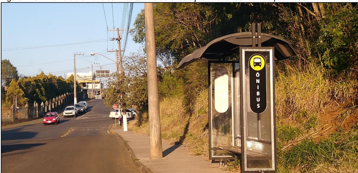
Figura 119 – Ponto de ônibus com faixa livre de circulação inferior ao mínimo permitido
