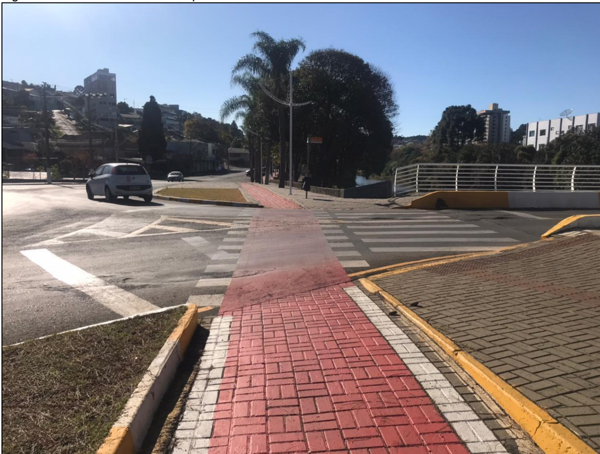
Figura 83 - Travessia sinalizada para ciclistas
