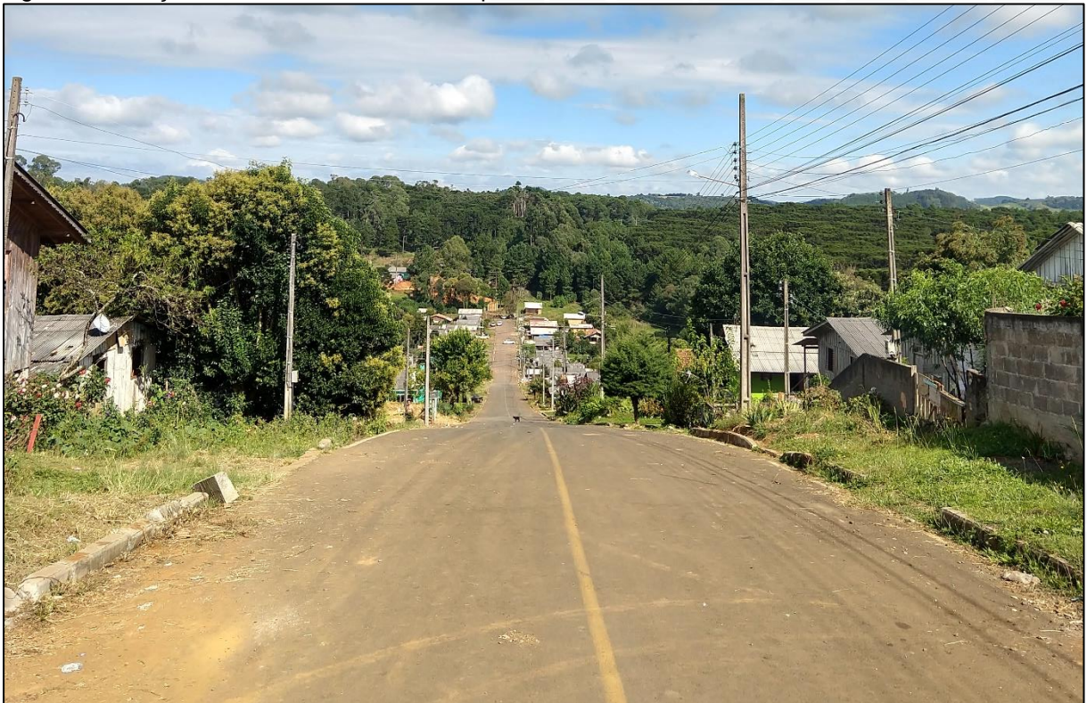
Figura 65 - Calçada na rua E Loteamento Taquara Verde
